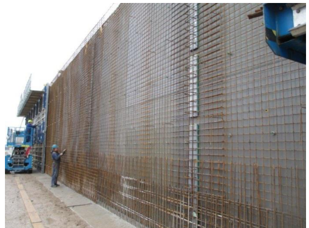
Figuur 9: Wapening vlechten 1-zijdig bekiste betonwand
