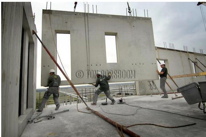
Figuur 11: Plaatsen prefabbetonwand
