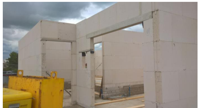
Figuur 12: Ingemetselde betonlatei
